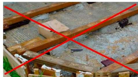
Při upevňování nosníků ponechte mezi podélnými konci nosníků 10mm mezeru.
